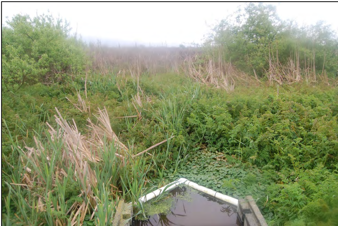
Photo 30 - Treatment Wetland 3- Effluent box
